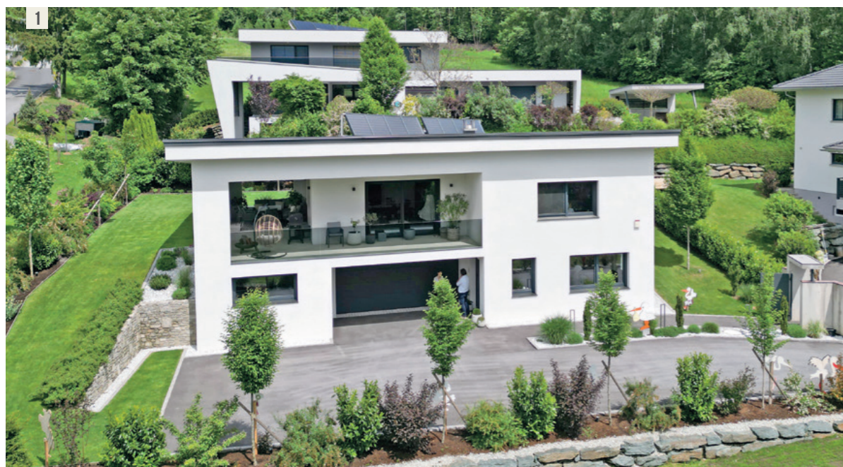
Der Neubau der Familie Höfler wird mit einer Wärmepumpe 1155-06 PC (6 kW) mit Ringgrabenkollektor von KNV geheizt und passiv gekühlt. Solarenergie wärmt die Sole vor.
