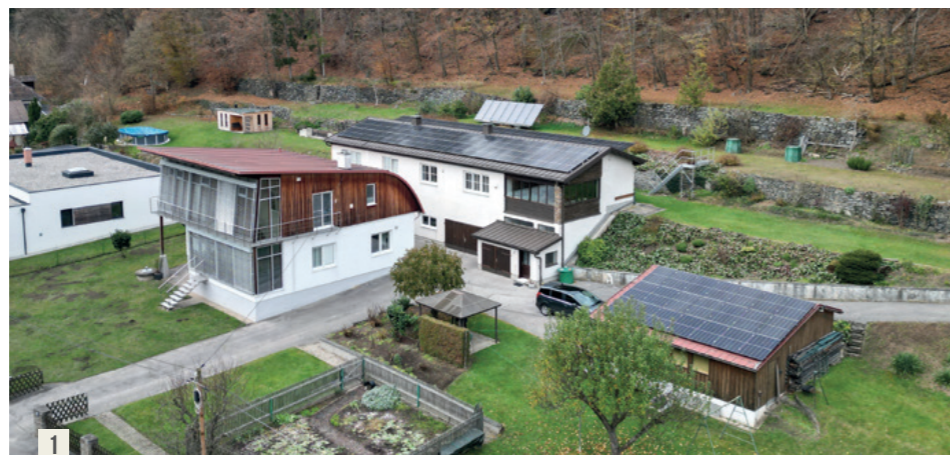
Die beiden Wohnhäuser werden über zwei Luftwärmepumpen, einen bei Bedarf zuschaltbaren Pelletskessel, eine Solaranlage und eine PV-Anlage mit Stromspeicher energetisch versorgt.
