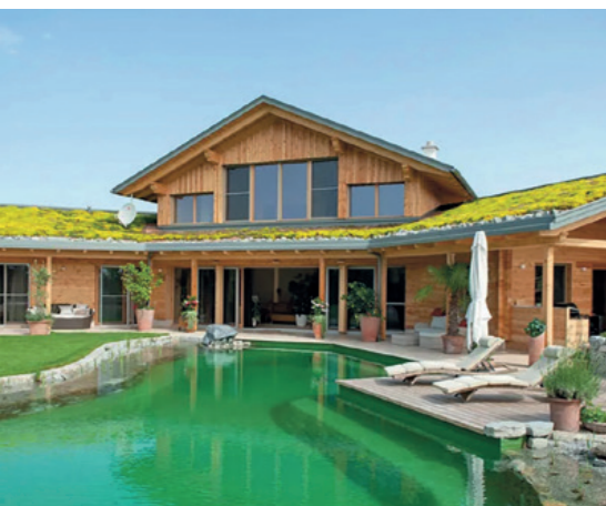
Ökohaus mit Erdwärmepumpe/Flächenkollektor
