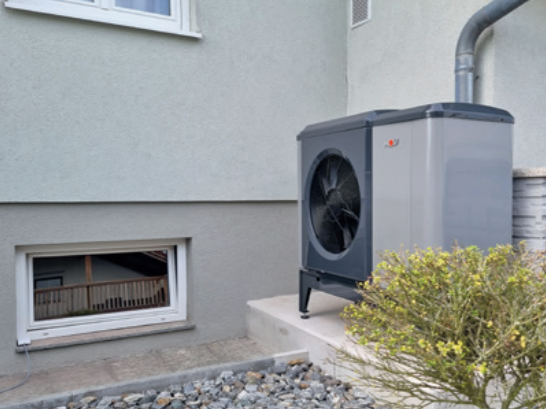
Außeneinheit einer Monoblock-Luftwärmepumpe
