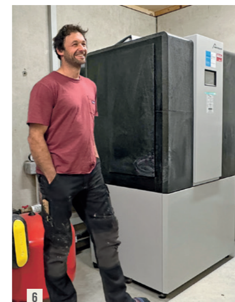
[6] Hausherr Max Dünßer ist Architekt und hat das Haus Blässe selbst entworfen. Geheizt wird hier mit der Luftwärmepumpe MOZART81-RW50 von BÖSCH für die Innenaufstellung.
